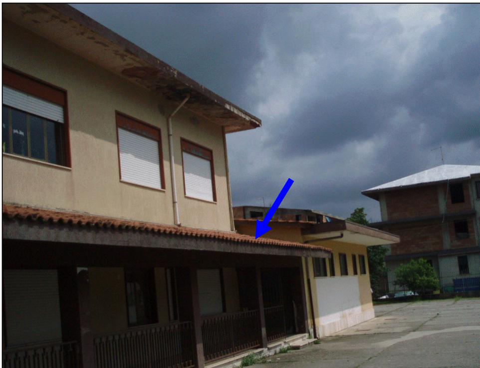
*Posa di gronda in alluminio su copertura posta sul fronte dell'edificio*
